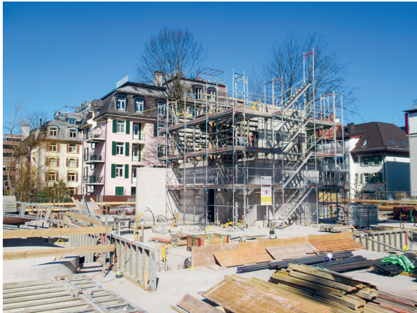
Treppenhaus mit Liftschacht. Roland Heller Foto
